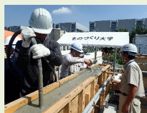
模擬壁部材へのコンクリートの打込み・締め
