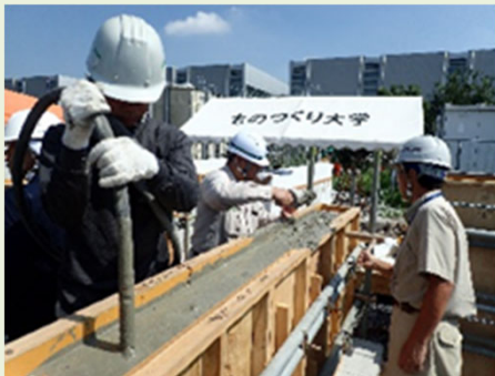
模擬壁部材へのコンクリートの打込み・締固め
